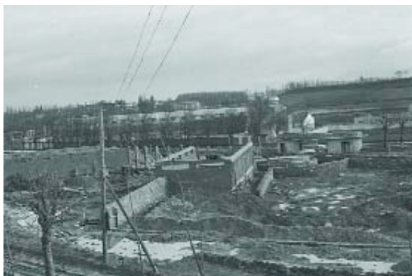
El Estadio en Obras.
